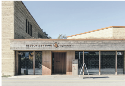
Besucherzentrum Vogelwarte Architektur: :mlzd, Lehm Ton Erde, Baukunst GmbH 2010-2015 / Foto: Daniela Arnold, 2020, Hochschule Luzern – Technik & Architektur
